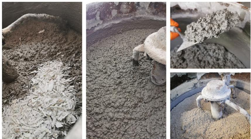
Preparazione del nuovo conglomerato con fibre di vetroresina riciclata
