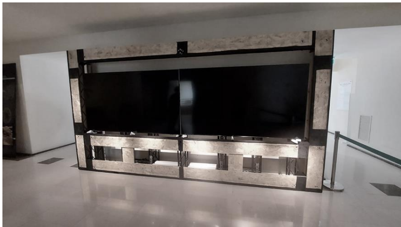
Installazione della struttura di sostegno e sistema di multivisione
