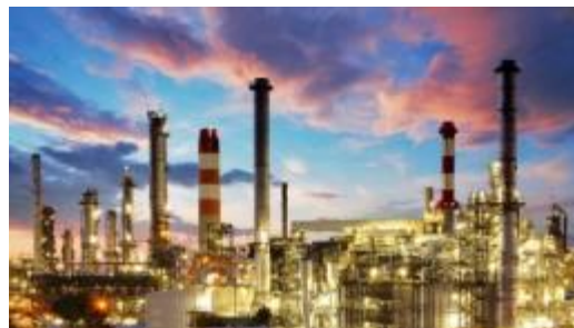
Materiali di scarto provenienti da attività industriali hanno potenzialità applicative nei materiali per il settore civile
