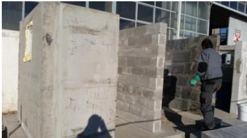
SUSCON – Costruzione di edifici pilota con prodotti SUS-CON (blocchi e pannelli)
