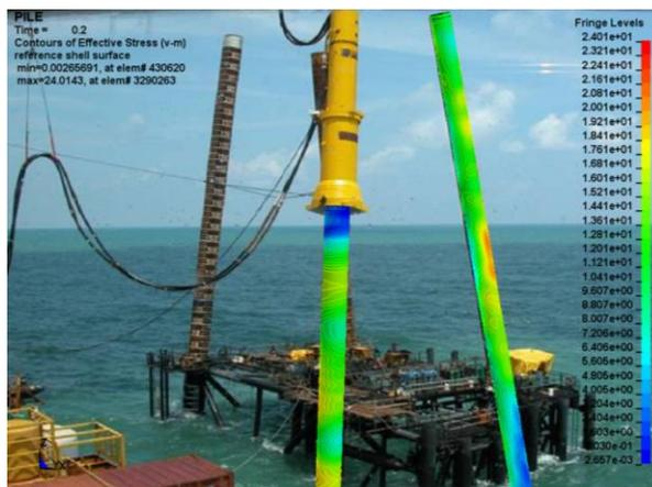
14-262-Simulazioni delle operazioni di battitura dei pali di fondazione in acciaio per piattaforme Offshore
