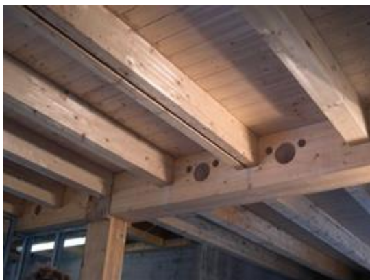
Esempio di strutture lamellari FRP-Legno (Fonte Internet)
